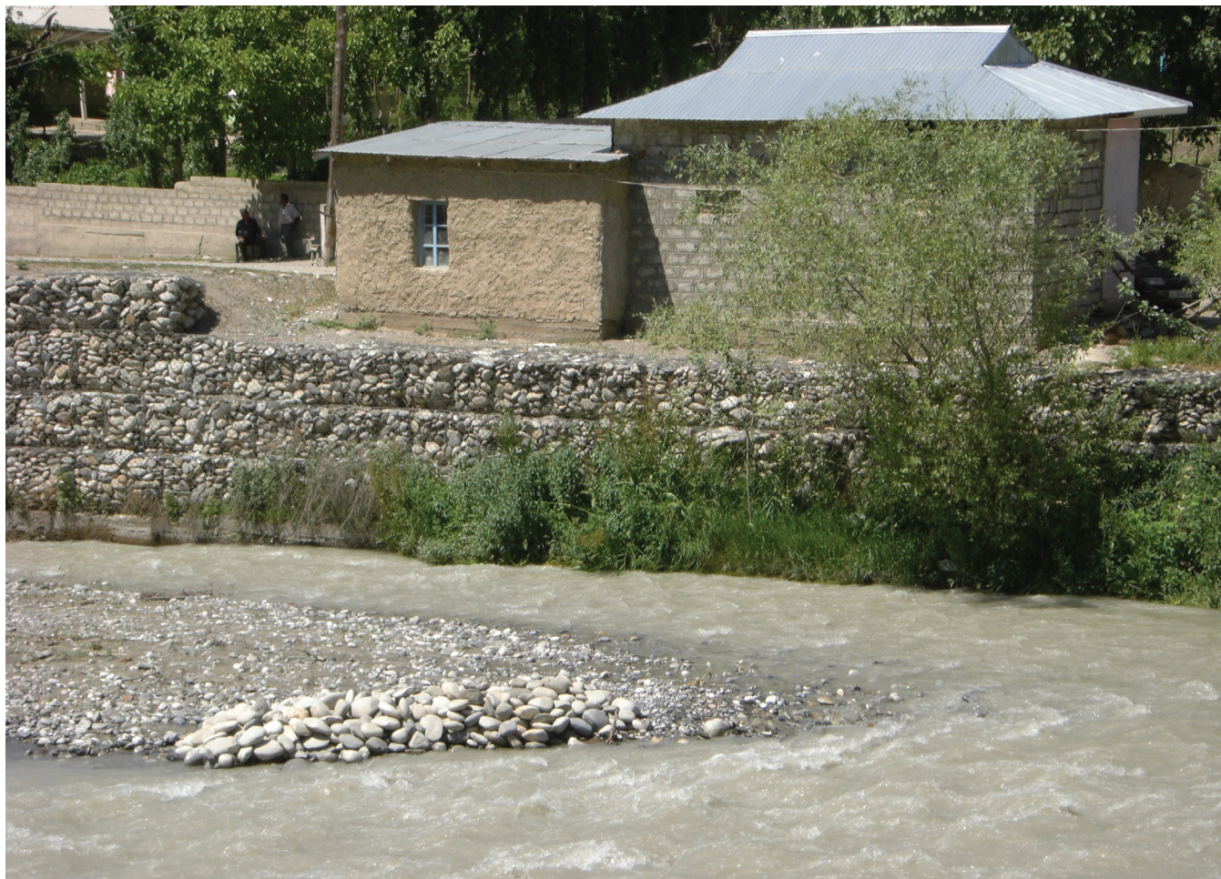
Рисунок 7 В верхней части водораздела были возведены каменные стены для защиты от ливневых паводков домов, расположенных близко к берегу реки. АВП Хожо-Бакырган, Кыргызстан. (Фото: Dominic Stucker, 2011).
