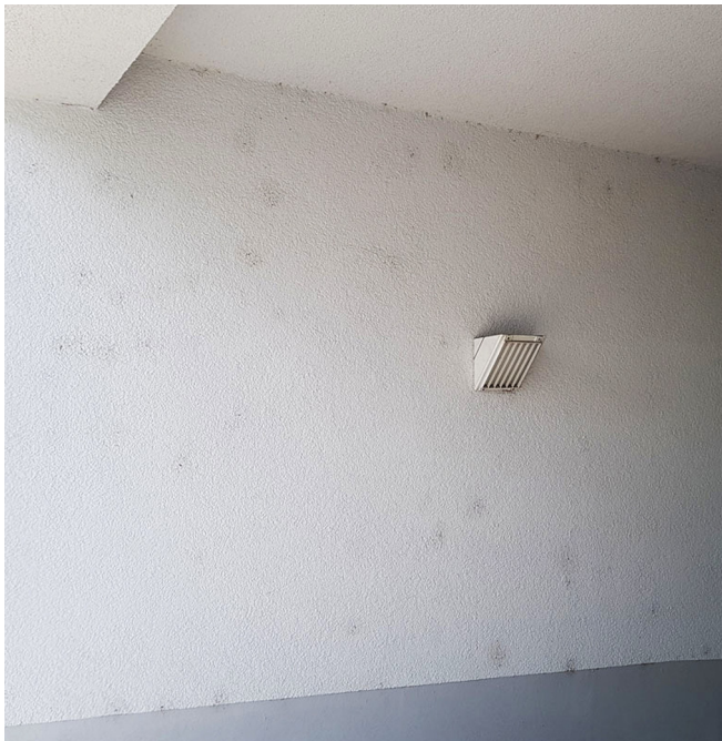
Abb. 2: Ein typisches Bild verunreinigter Netze von Brigittea civica an einer weiß verputzten Wand
